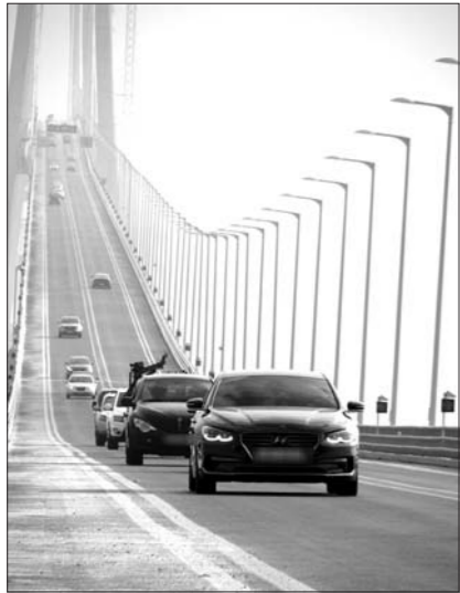
설 귀성행렬이 본격화된 2일 오전 신안군 압해도와 임대도를 연결하는 '천사대교'가 섬 지역 고향을 찾는 차량들로 붐비고 있다. 천사대교는 설을 맞아 1일부터 7일까지 임시개통한다. 뉴스
